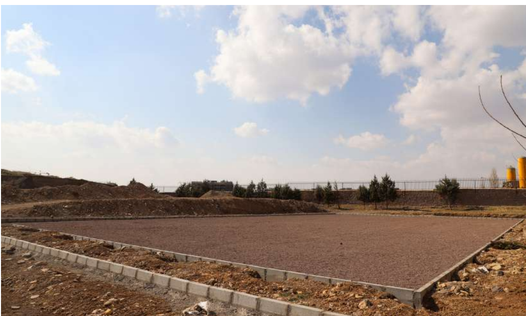
احداث زمین چمن مصنوعی مجتمع خوابگاه دختران متراژ: ۱۲۰۰ متر مربع تاریخ شروع: شهریور ۱۴۰۱ درصد پیشرفت: ۸٪
